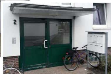
Die Türen vor der Modernisierung
