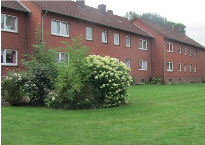
Unsere Häuser in der Eberhard-Ries-Straße nach der Hohlschichtdämmung
